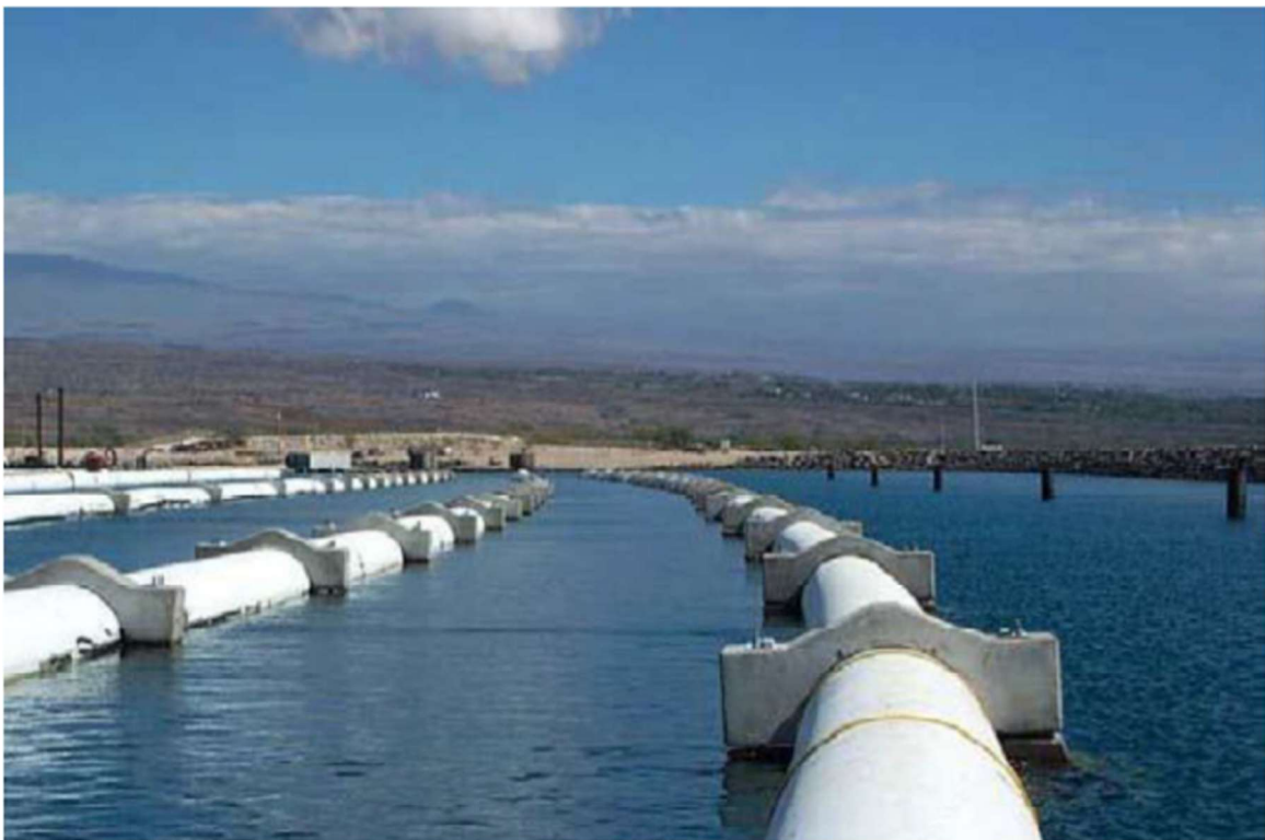
Joonis 1-4. Joonisel on näha üks võimalik lahendus, kus torudele on paigutatud betoonplokkidest raskused, mis hakkavad hoidma toru merepõhjas. Allikas: Sustainable Energy Solutions Sweden Holding AB.
