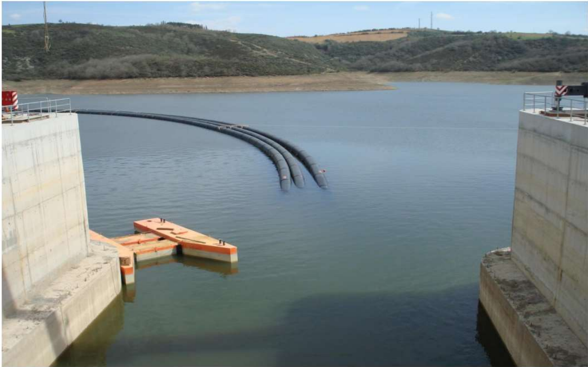
Joonis 1-3. Mereveevõtu toru võib koosneda ka mitmest väiksema läbimõõduga torust. Allikas: firat.com
