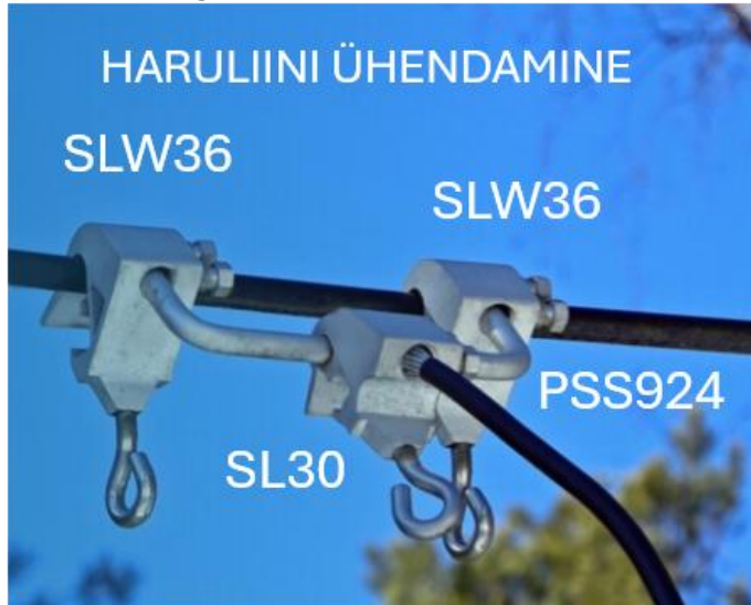
Joonis 3.1 – Haruliini ühendamine mastil 110.
