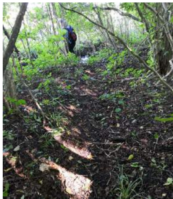
Foto 8. Vaade kraavi 105 suubumisele eesvoolu 100, MP5 juures. Suue ummistunud, ühendus puudub.
