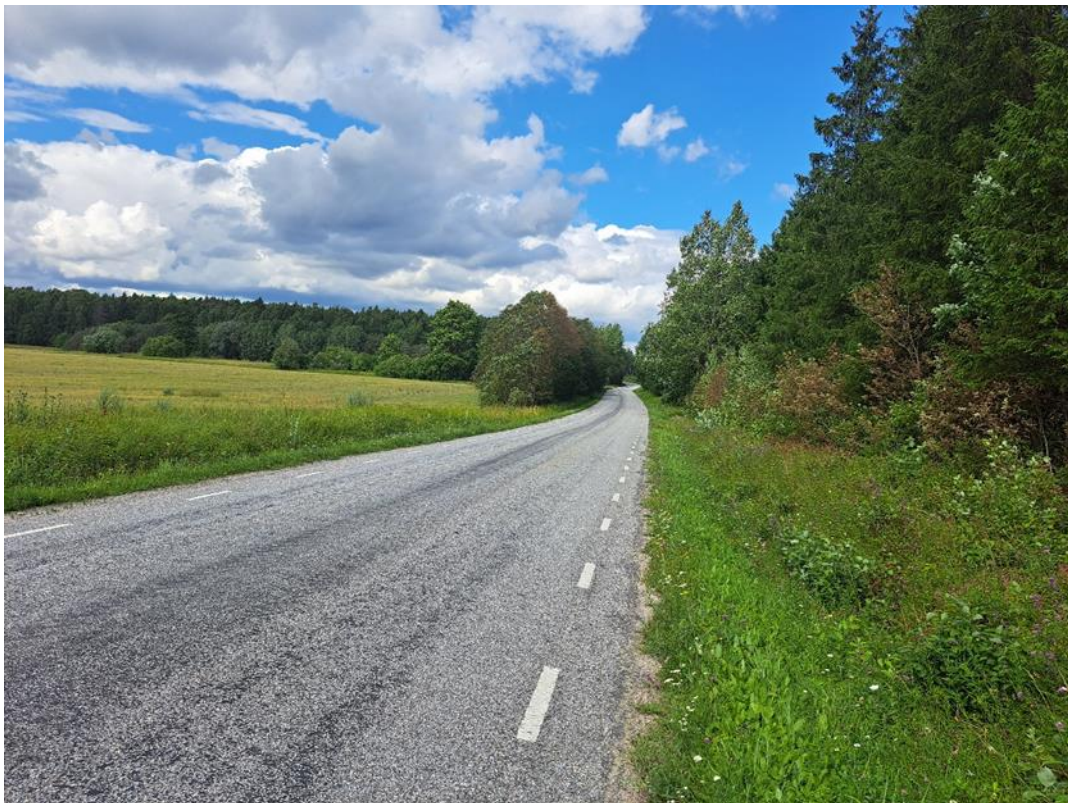
Foto 2 Pähu tee projekteeritava ristimiku asukoht, vaade põhja (allikas: Reaalprojekt OÜ 18.07.2024)
