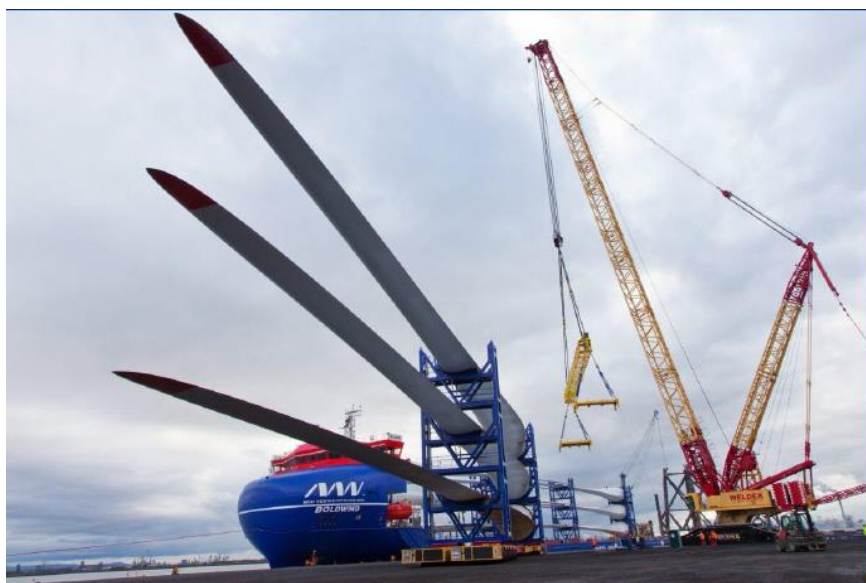
Joonis 24. Tuuliku labad ja nende paigalduse ettevalmistus sadamas
