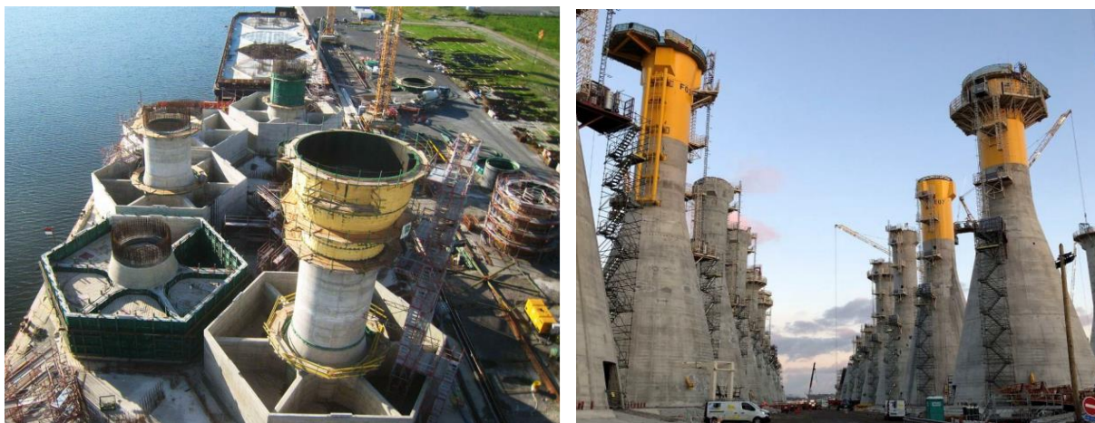
Joonis 18. Võimalikud gravitatsioonivundamendi lahendused. Allikas: Loode–Eesti meretuulepargi eel-tasuvusuuring Hiiu OWF Pre-Feed: Available Technology and Engineering Practices
