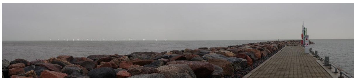
ALTERNATIIV 1 JA 2 - 7MW TUULIKUD. VAADE ARENDUSALALE TP 1
