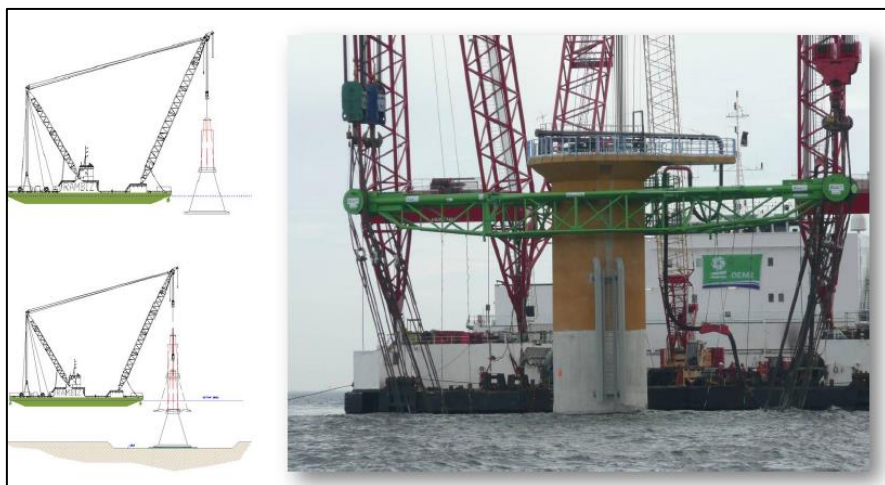
Joonis 27. Gravitatsioonivundamendi transport ja paigaldamine
