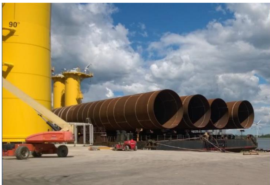
Joonis 22. Tuuliku torni elemendid ja nende paigalduse ettevalmistus sadamas
