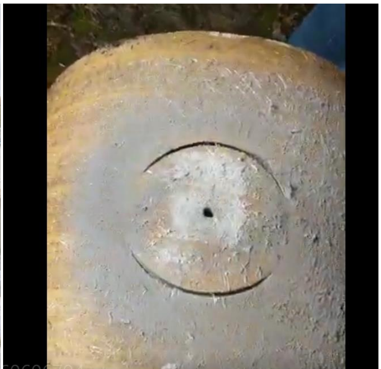
Foto 2. Sarnase GRP toru puurimine
