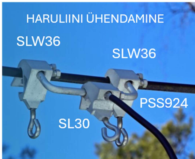
Joonis 3.1 – Saatse kooli haruliini ühendamine mastil 177H11 (endine nr 8).
