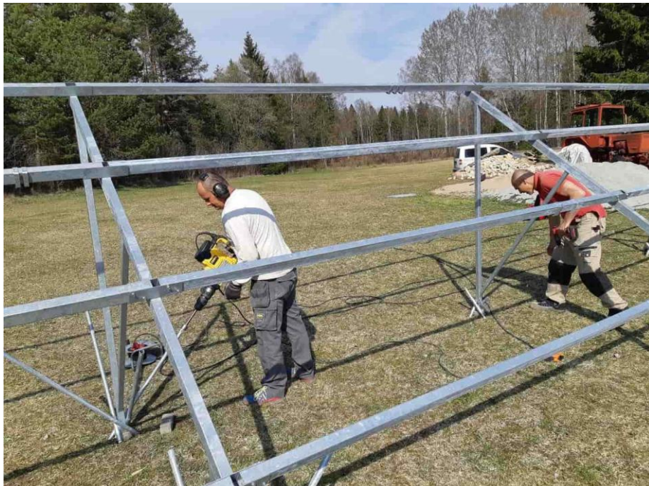
Taastuenergia OÜ maaraami TreeSystem paigaldamine 2019
