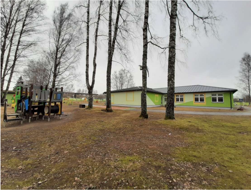
Foto3 – vaade loode suunast lasteaia hoonele ja mänguvahenditele
