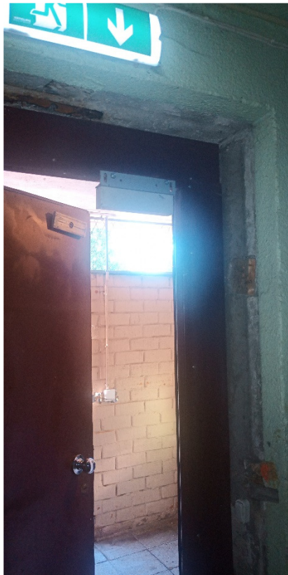
Pilt 8. Suitsuvaba trepikojast õue viiv uks on võtmeta avatav. Varustatud magnetlukuga. Elektri puudumisel on avatav ka võtmeta. Ukse ees olev ala on puhas. Prügikonteinerid asuvad õuses.
