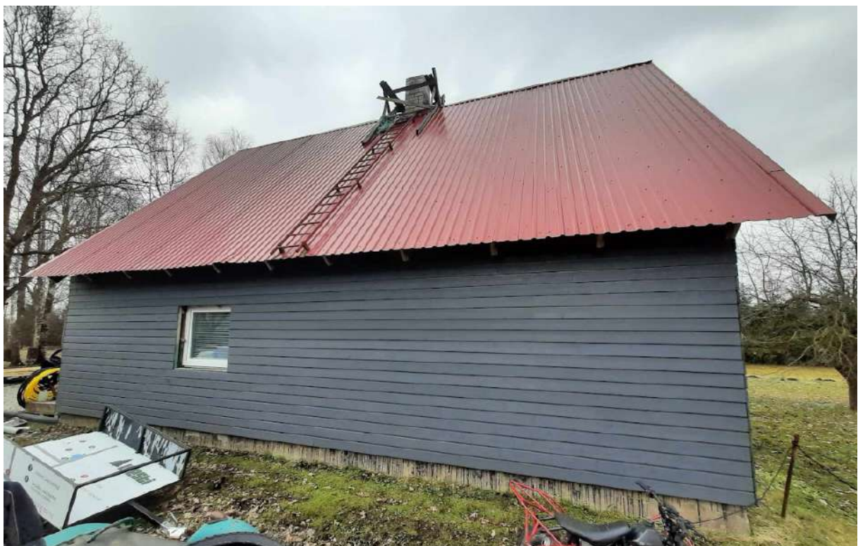
Foto 2 - Vaade olemasolevale elamule loodest
