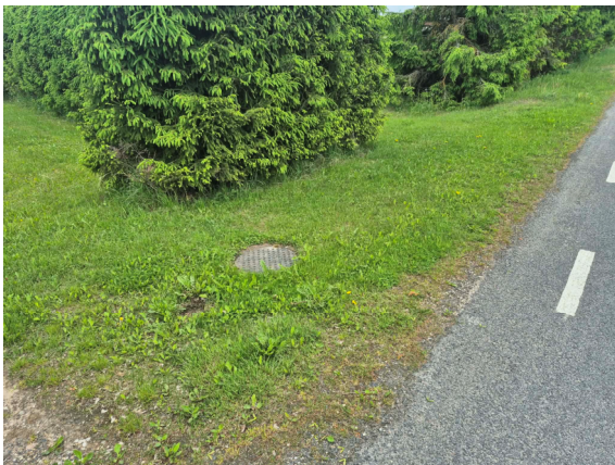
Pilt 1. Olemasolev läbipesu-kaev olemasoleva veetorustikuliini lõpus
