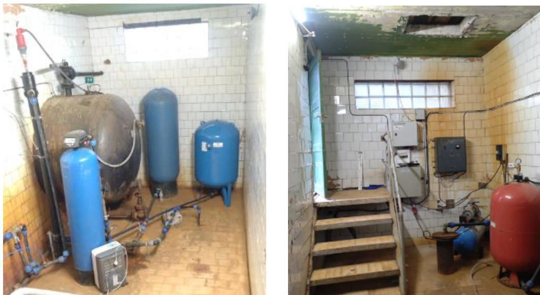
Fotod: Äksi keskuse puurkaev-pumbamaja seadmetest
