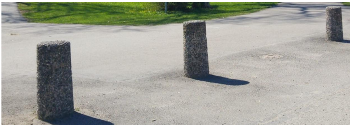
Foto 7. Kiili Betoon piirdepost 12.8 12 .
