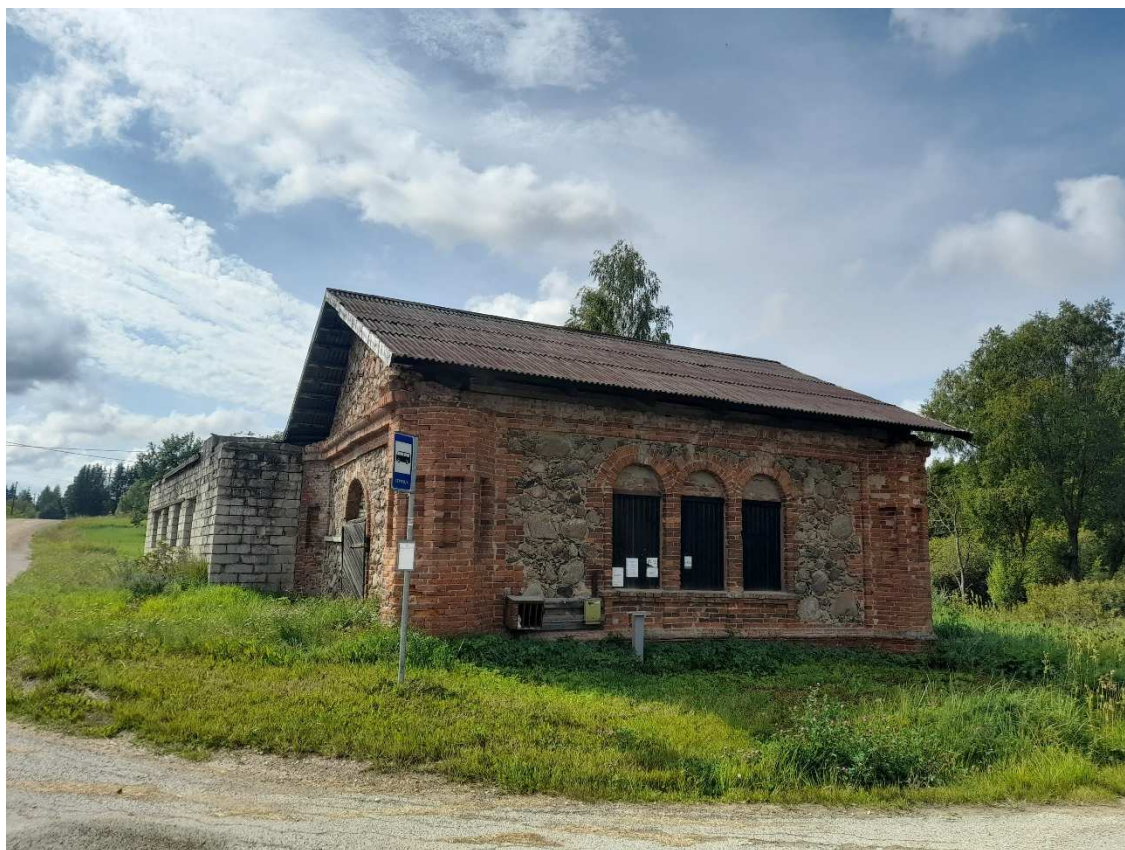
Foto 4. Hoone idapoolne fassaad. Foto Anu Lepp, 18.08.2023
