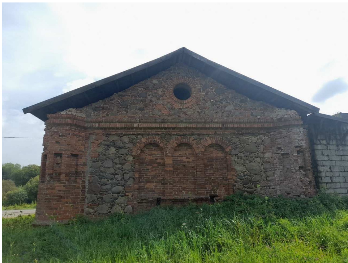
Foto 5. Hoone idapoolne fassaad. Foto Anu Lepp, 18.08.2023
