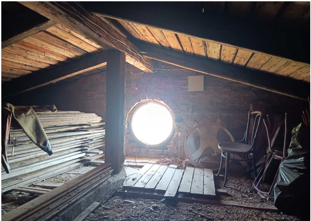
Fotod 10–20. Katusealune ja -konstruktsioon. Fotod Kai Nõva, 15.06.2023.
