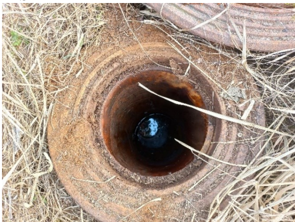
Foto 1. Sademeveekanaliseerimise kaevu SK5 vaade
