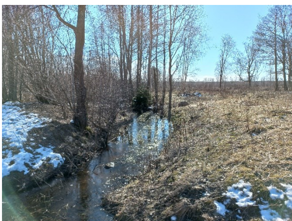
Foto 21. Vaade kogujakraavile tunneli T18-3 sissevoolu poolt
