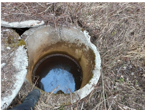
Foto 3. Regulaatorikaevu SK2 vaade
