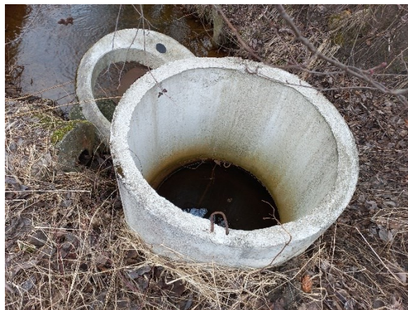
Foto 2. Regulaatorikaevu SK1 vaade
