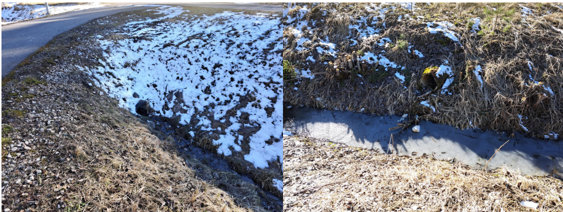
Fotod 7 ja 8 Kengu tee alust läbiv trupp ja Vissi – Peedumäe tee alt teekraavi suubuv DN400 trupp
