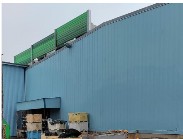
Joonis 3. Hoonete katusele ja fassaadi küljele paigaldatud soojusvahetid
