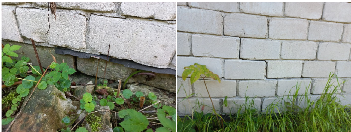
Fotod 6, 7. Vundamendis ja välisseinas olevad praod
