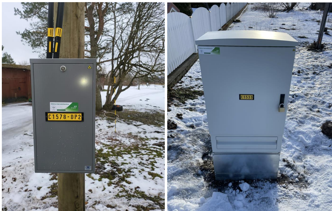
Pilt 1. Vahejaotuskapp (vasak) ja peajaotuskapp (parem)
