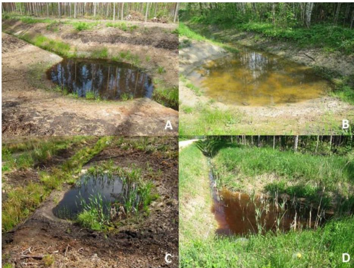
Joonis 29. Erinevat tüüpi kraavilaiendid: kahepoolne laiend 8 × 8 m (A), ühepoolne laiend 10 × 5 m (B), valliga laiend 3 × 6 m (C), nurgalaiend (D). Kõik kujutatud laiendid on sobilikud kudemispaigad. Alus: Vaikre jt 2019.
