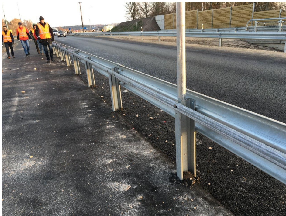
Joonis 5: Kergliiklejatele mõeldud metallist ribaga pörkepiirde näidis
