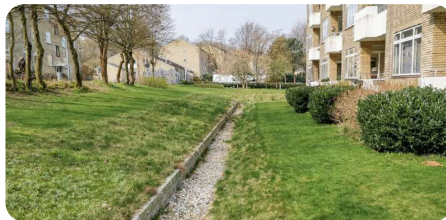
Täidisdreen kortermaja vundamendi kaitseks sõiduteelt valguva sademevee eest. Kopenhaagen, Taani. Foto: Gen Mandre.
