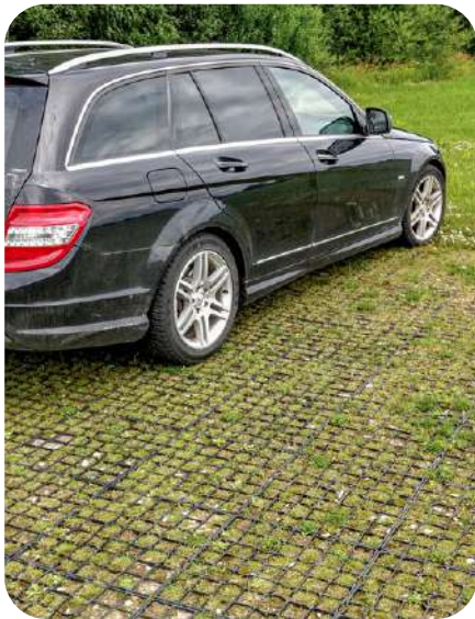
Vasakul: Plastkärg väiksema kasutuskooomusega parklas. Eesti. Foto: Gen Mandre. Paremal: Vahedega sillutuskivid. Tartu, Eesti. Foto: Gen Mandre.
