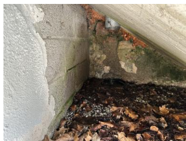
Foto 4. Olemasoleva vihmaveetoru ots rõdule viiva trepi all. Trepp likvideeritakse.
