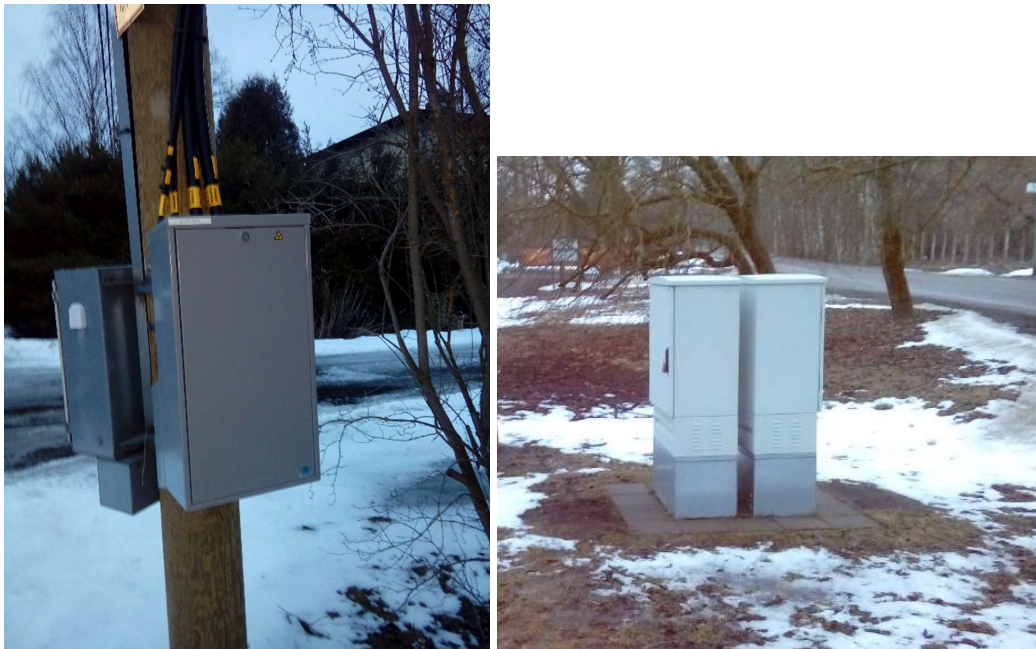
Pilt 1. Vahejaotuskapp (vasak) ja peajaotuskapp (parem)
