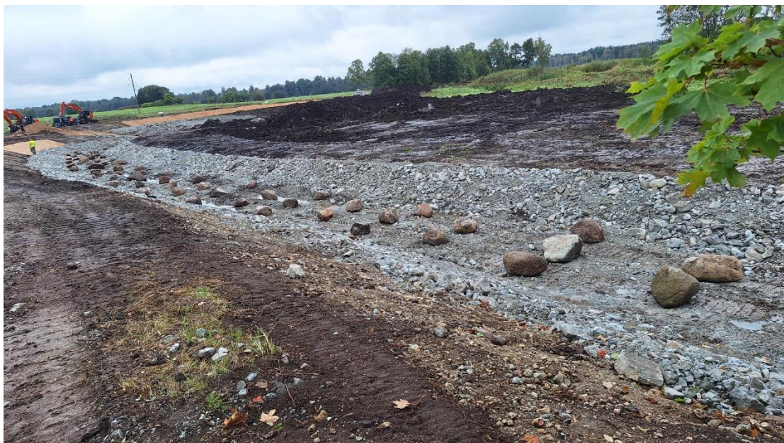
Pilt 5. Kärestiku voolurautuskivide paigaldus.
