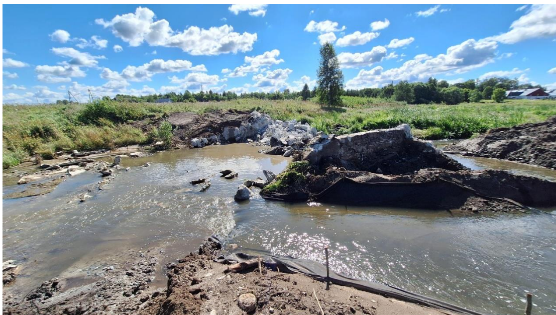
Pilt 1. Lammutatud ülevool.
