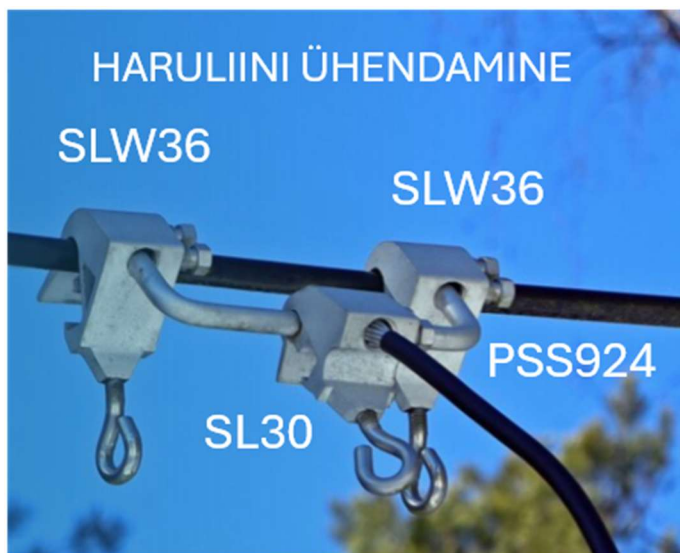
Joonis 3.1 – Ritsike haruliini ühendamine mastil 236.
