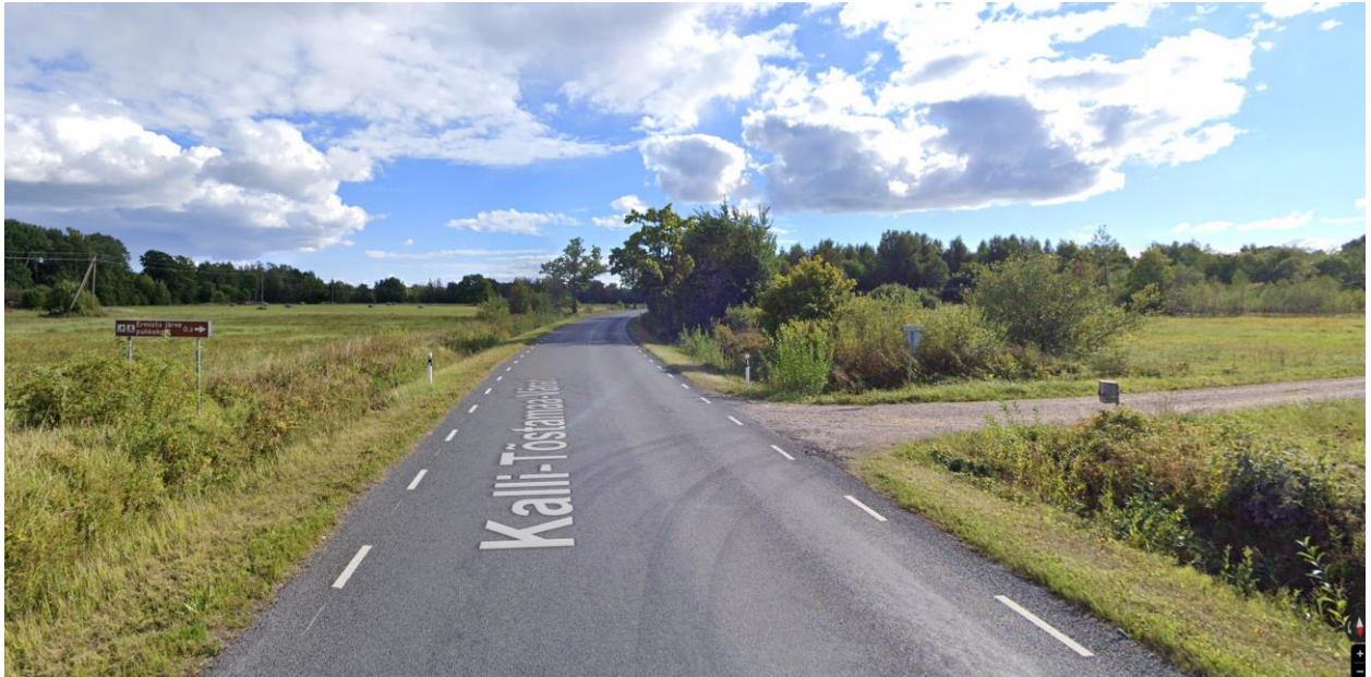
Pilt: Objekti algus (Supluse tee paremal), vaade põhjast lõunasse
