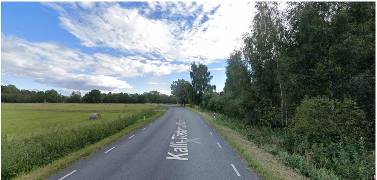
Pilt: Teeületuskoht pk 3+16, vaade põhjast lõunasse
