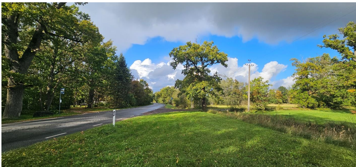
Pilt: pk ~8+20 vaade lõunast põhja
