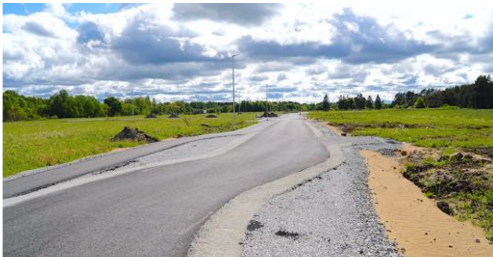
Foto 6: Vaade planeeringuala põhjaservast, Kõrre maaüksusele teede ja trasside rajamise seis 2023 aasta juunis.
