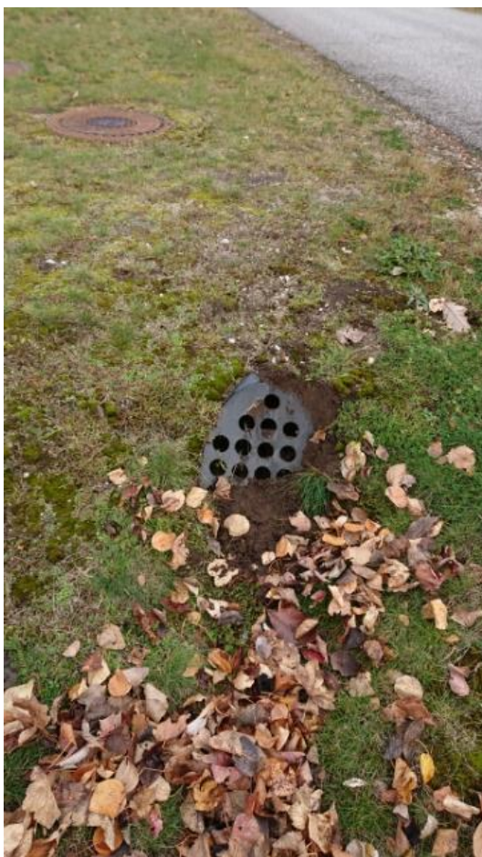
Foto 1 - drenaažitoru sissevoolu resti näide
