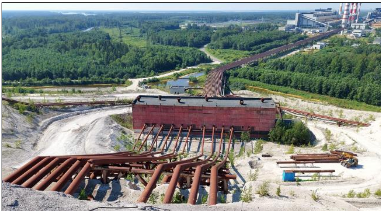
Foto 2.1.1 Eesti Elektrijaama tuhavälja pulbitorustik (Enefit Power OÜ)
