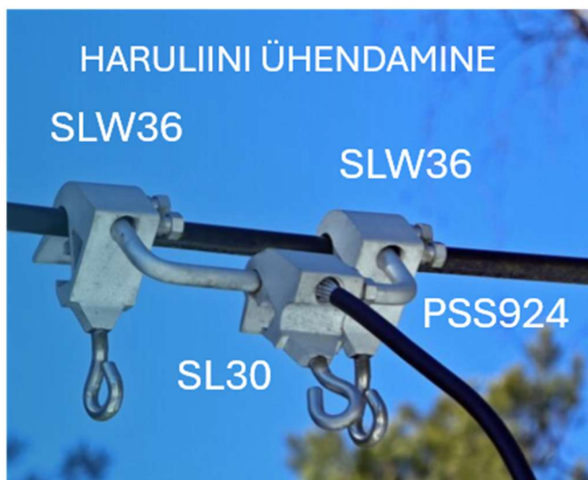
Joonis 3.1 – Kiläri haruliini ühendamine mastil 153.
