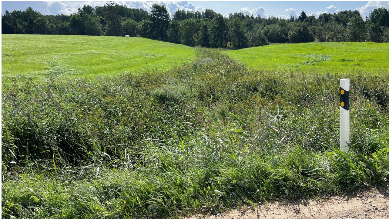
Foto 5. Vaade Konuvere-Sulu teelt suudmekraavile. Kraavi on kogunenud setted ja rohttaimestik. Pärast truubi hooldustöid on vajalik teostada ka suudmekraavi puhastamine setetest ja taimestikust.
