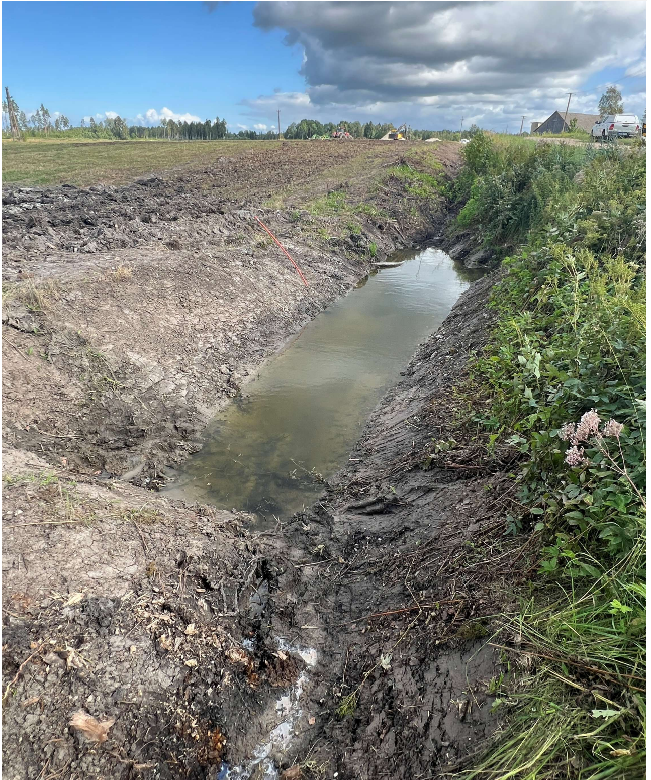
Foto 6. Maaomaniku poolt drenaažikollektorite otsimise käigus puhastatud eesvool ja tekkinud süvend, mis peale truubi hooldustööde lõppu tuleb taastada esialgsele kujule.
