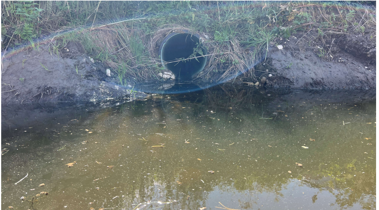
Foto 3. Vaade Konuvere-Sulu tee km 2,143 truubi sissevoolule. Truup D500.
