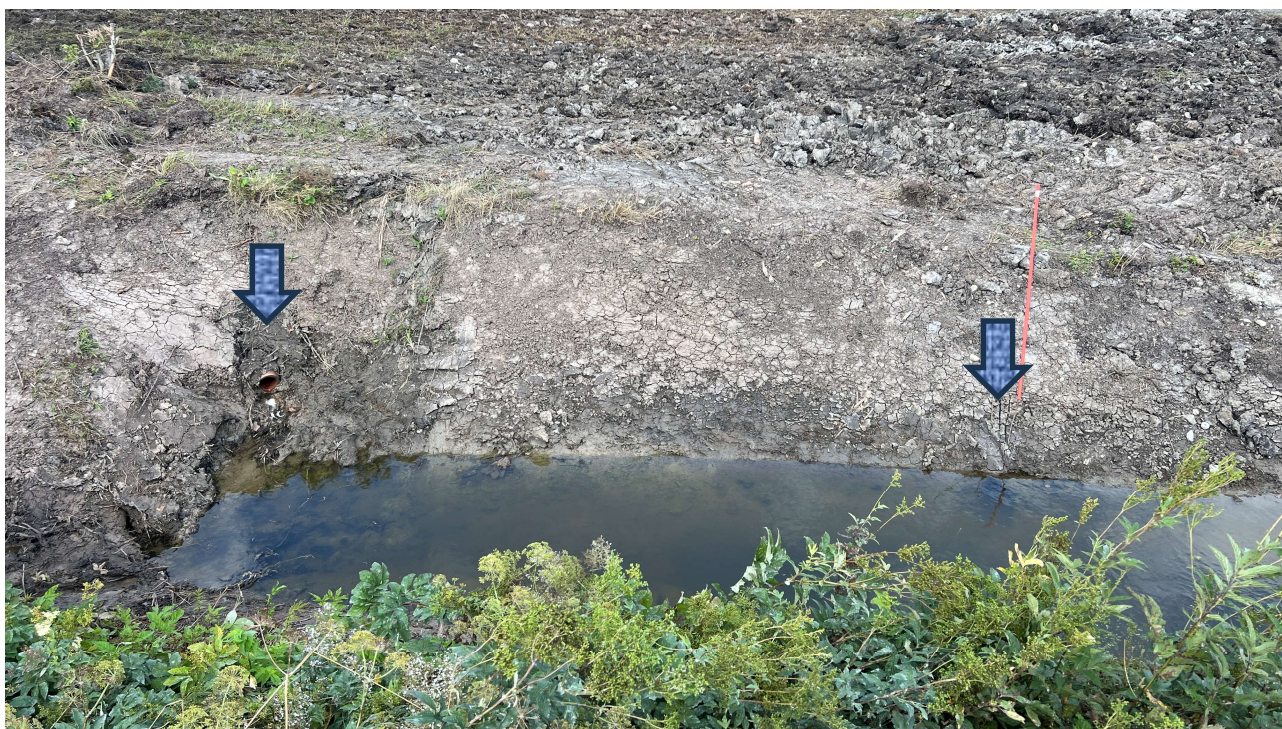
Foto 1. Vaade kõrvalmaantee ääres olevale kraavile, milles on näha kahte drenaazikollektori suuet. Parempoolne suue on ca 27 cm vee all.
