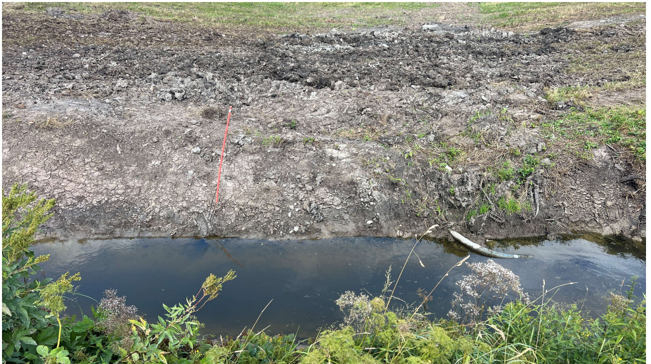
Foto 2. Vaade vee all olevale drenaažikollektori suudmele. Paremäl on näha maaomaniku paigaldatud lokaalset drenaažitoru põllumaa liigniiskuse leevendamiseks.
