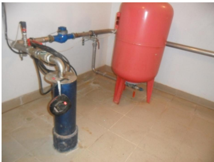
Joonis 5-12 Voose puurkaevpumpla sisevaade, puurkavu päis ja membraanhüdrofoor
