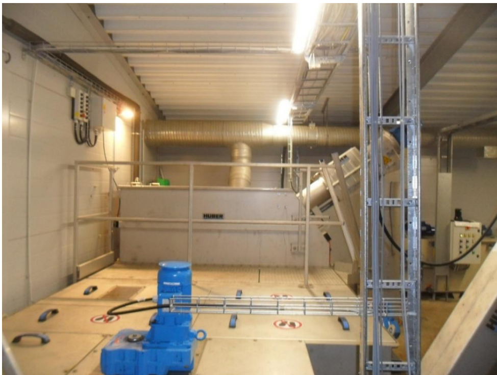
Joonis 6-2 Kehra reoveepuhasti sisevaade, automaatkruvivõre, liiva- ja rasvapüüdur
