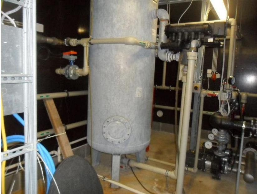
Joonis 5-6 Aegviidu Raudtee-Pärna (Keskalevi) pumplahoone sisevaade, vasakul kvartsliivfilter, paremal II-astme pumbad
