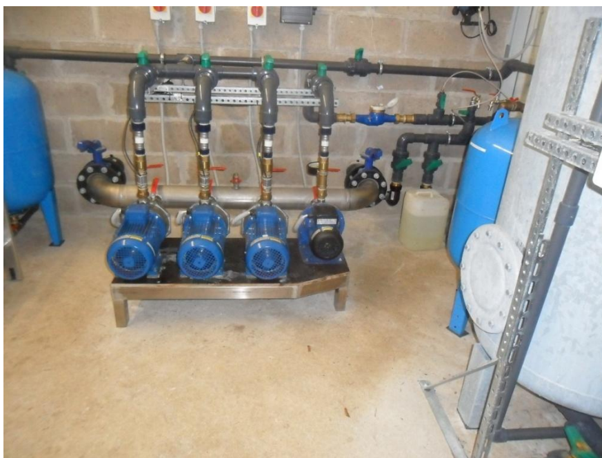
Joonis 5-8 Aegviidu Kosenõmme ja Poolemõisa pumpla ja VTJ sisevaade, keskel kolm II astme pumpa ja pesupump, paremal näha ühte paarisfiltritest
