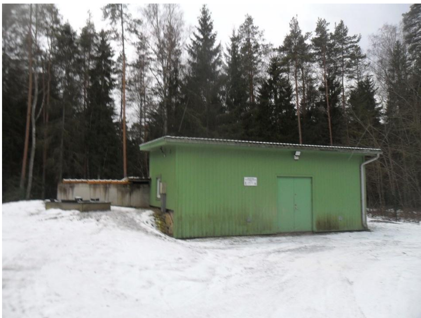
Joonis 6-5 Aegviidu reoveepuhasti välisilme (protsessimahutid asuvad vasakul väljaspool hoonet muldkehas)
