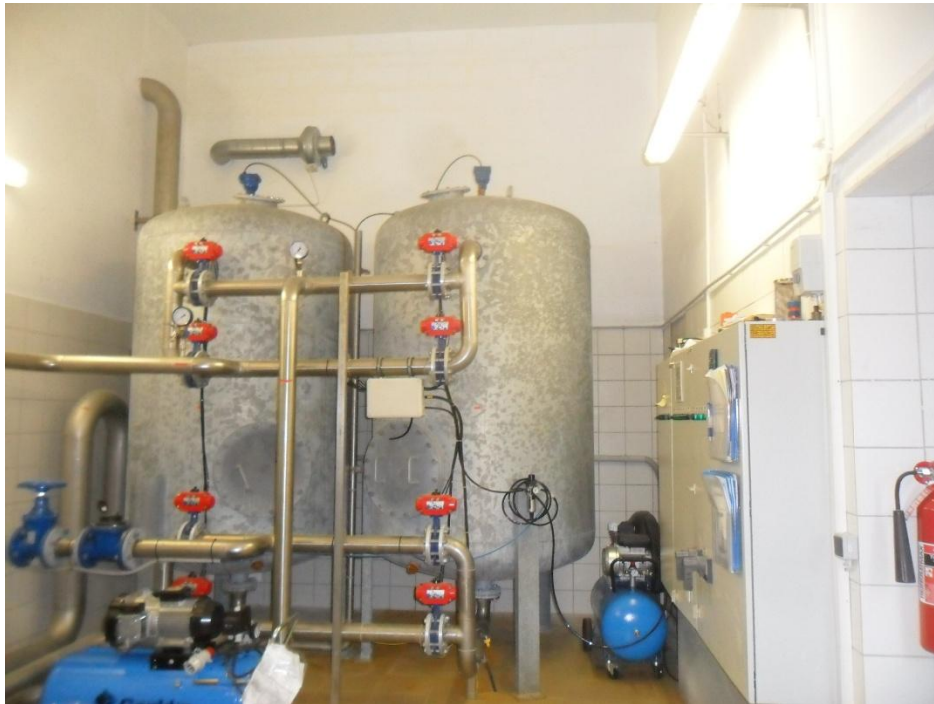
Joonis 5-3 Kehra veetöötus ja pumplahoone sisevaade, paarisfilter
