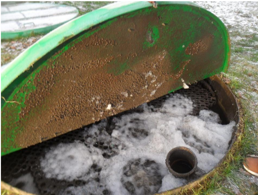
Joonis 6-7 Alavere reoveepuhasti reaktor ehk protsessimahuti/biokilepuhasti
