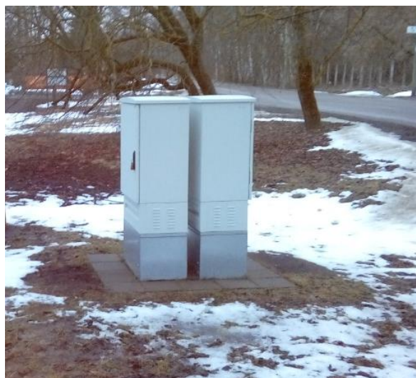
Pilt 1. Vahejaotuskapp (vasak) ja peajaotuskapp (parem)
