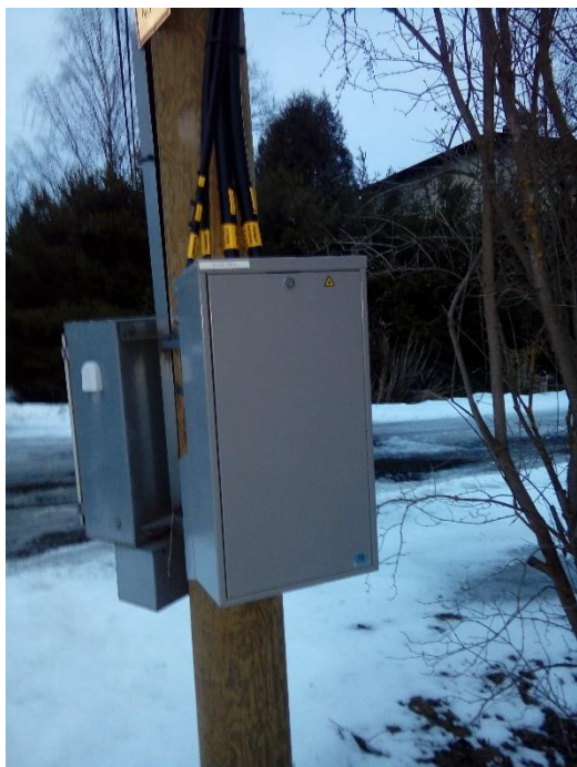
Pilt 1. Vahejaotuskapp (vasak) ja peajaotuskapp (parem)
