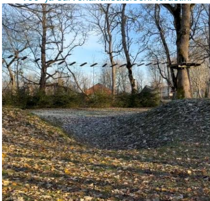
Foto 5 Lohk, kus maapind oli ette nähtud täita peale torustike paigaldamist sinna.
