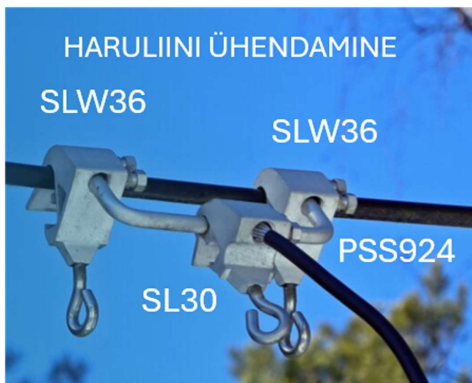
Joonis 3.1 – Haruliinide ühendamine mastidel 55, 30 ja 41 ning maakaabelliini ühendamine mastil 15 (vana nr 16).
