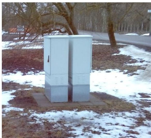
Pilt 1. Vahejaotuskapp (vasak) ja peajaotuskapp (parem)
