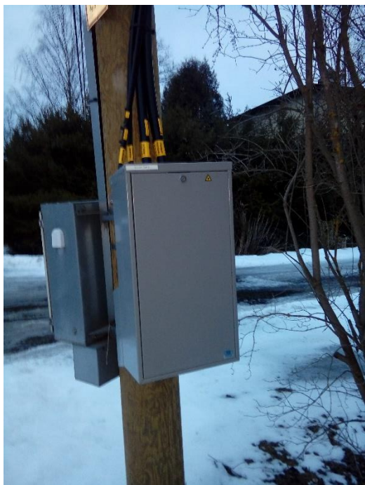
Pilt 1. Vahejaotuskapp (vasak) ja peajaotuskapp (parem)
