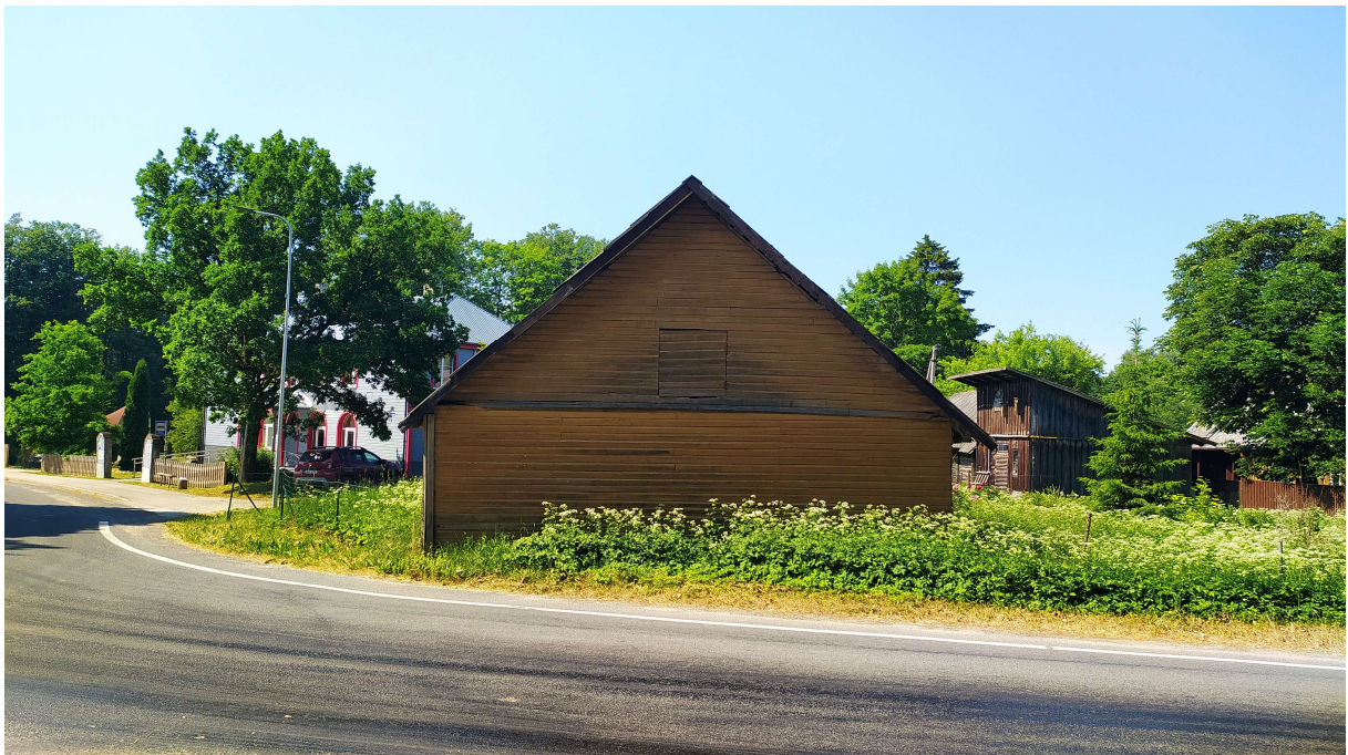
Foto 2. Vaade lammutatavale hoonele kirdest
