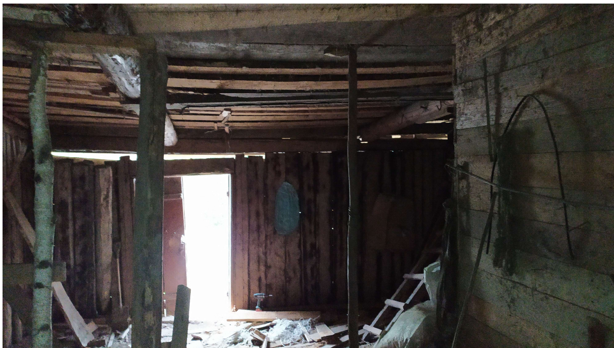
Foto 11. Vaade lammutatavale hoonele seest
