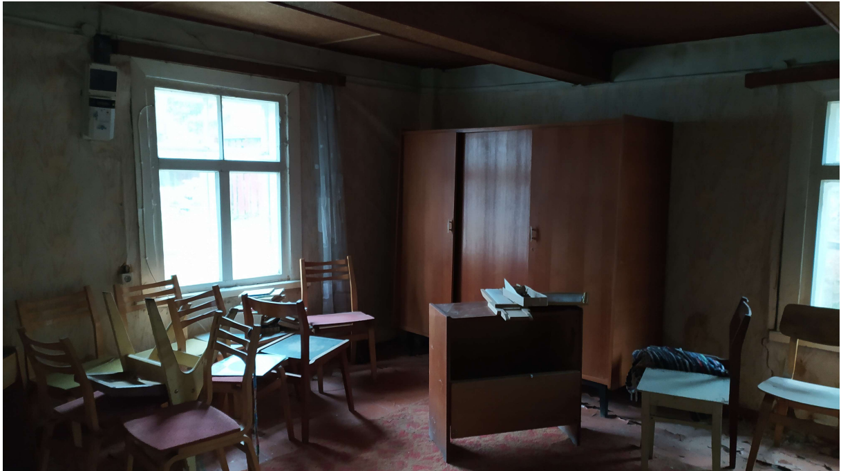
Foto 5. Vaade lammutatavale hoonele seest
