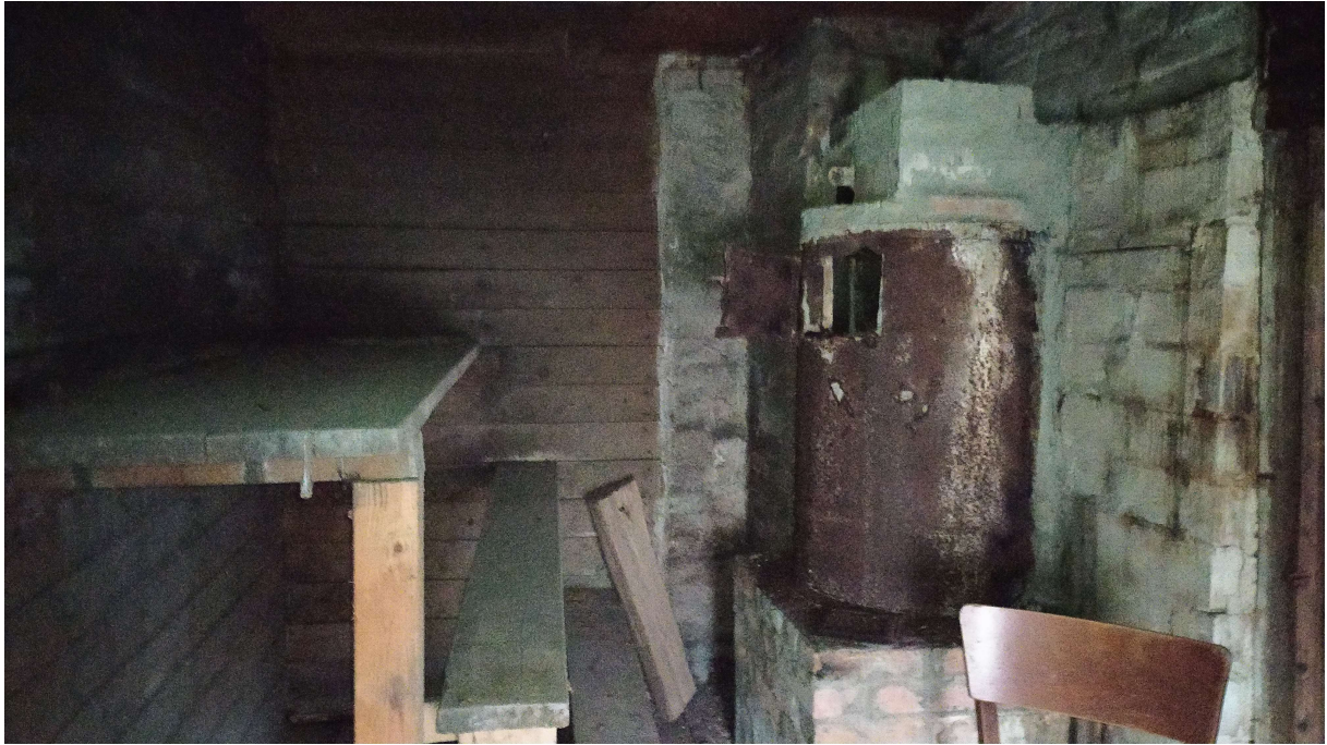
Foto 9. Vaade lammutatavale hoonele seest
