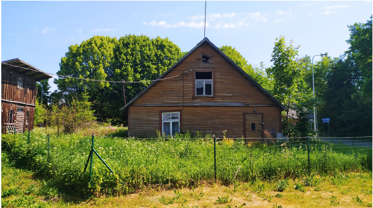
Foto 3. Vaade lammutatavale hoonele edelast
