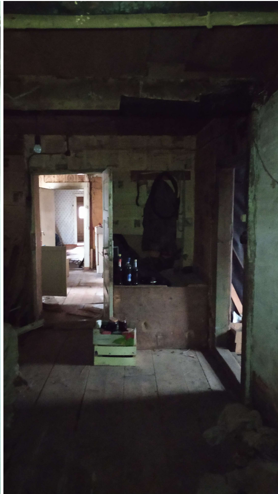
Foto 8. Vaade lammutatavale hoonele seest
