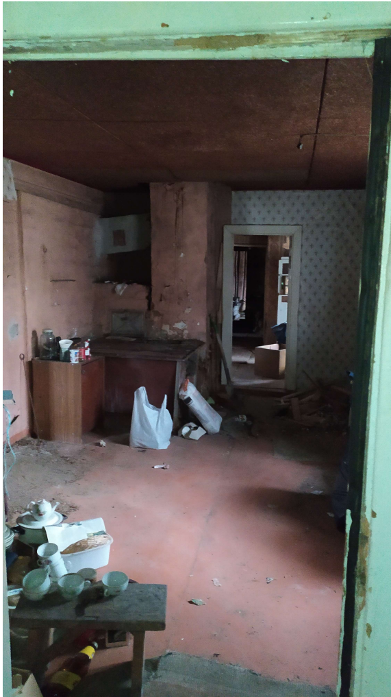
Foto 7. Vaade lammutatavale hoonele seest
