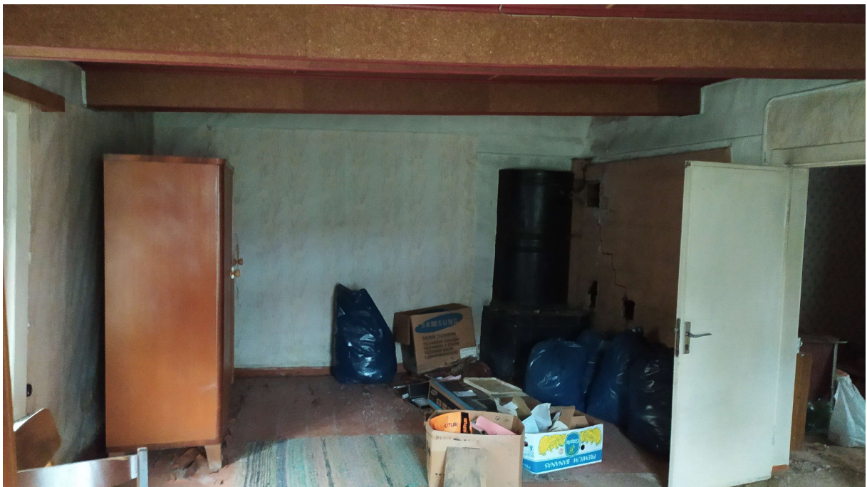
Foto 6. Vaade lammutatavale hoonele seest
