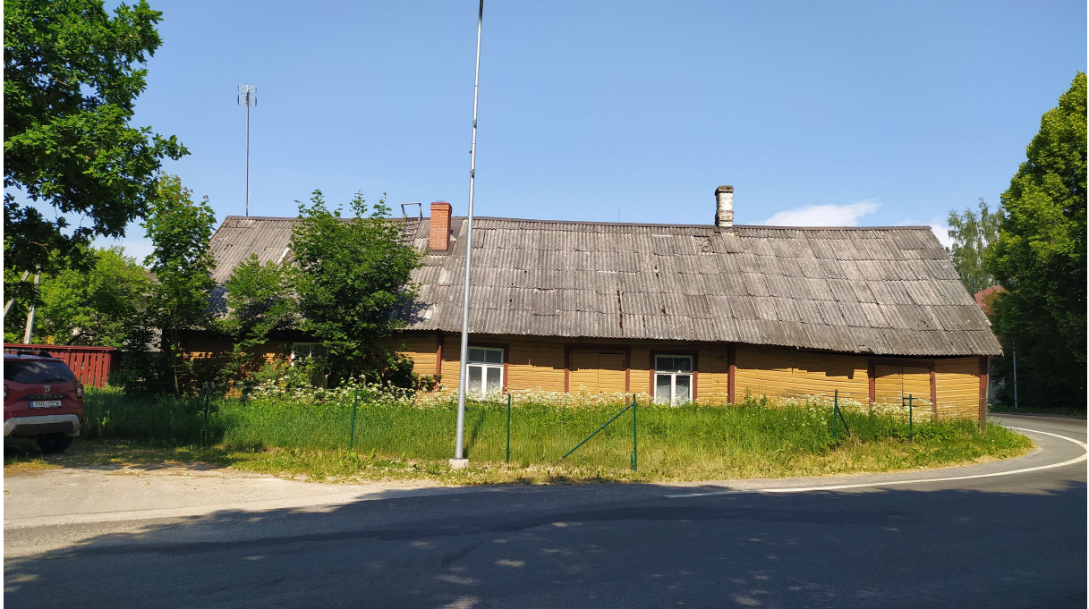
Foto 1. Vaade lammutatavale hoonele kagust
