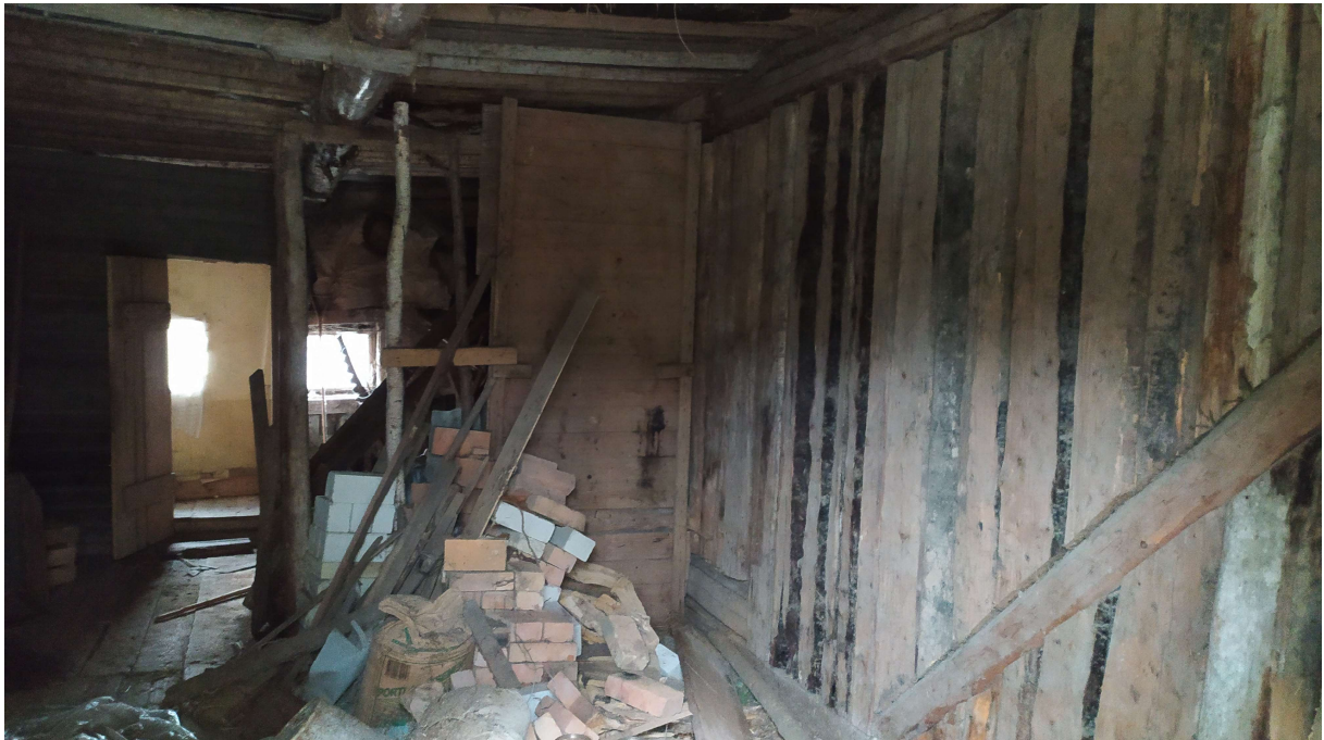
Foto 10. Vaade lammutatavale hoonele seest
