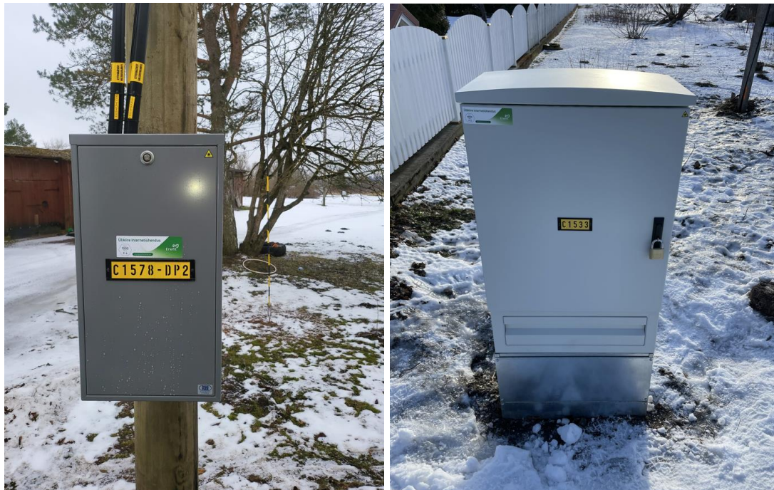
Pilt 1. Vahejaotuskapp (vasak) ja peajaotuskapp (parem)
