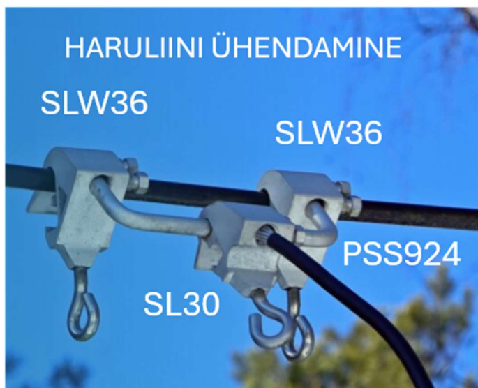
Joonis 3.1 –Haruliinide ühendamine mastidel 77, 87, 104 ja 111.
