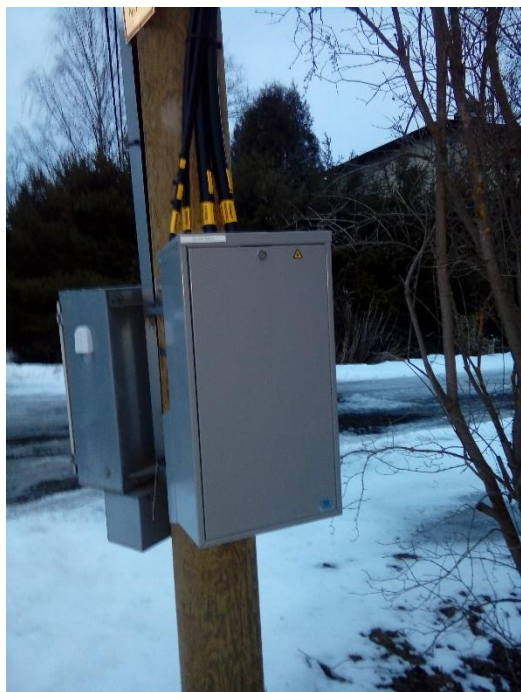
Pilt 1. Vahejaotuskapp (vasak) ja peajaotuskapp (parem)
