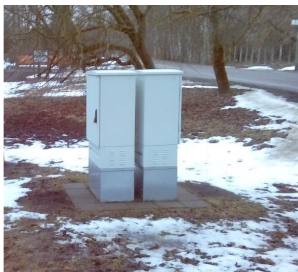
Pilt 1. Vahejaotuskapp (vasak) ja peajaotuskapp (parem)
