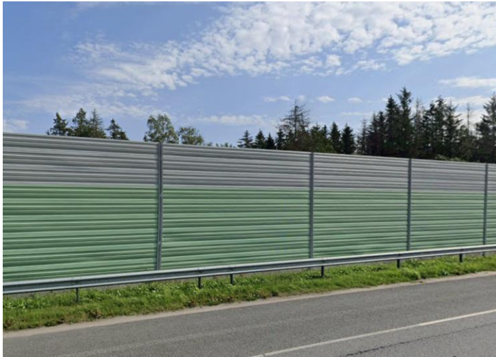
Joonis 2. Foto ol.olevast müraseinast.
