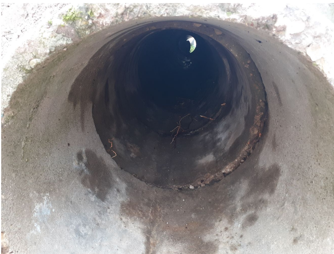
Foto 3, truubi sisevaade jõe poolt, kaks viimast toru on omavahel pisut nihkes.
