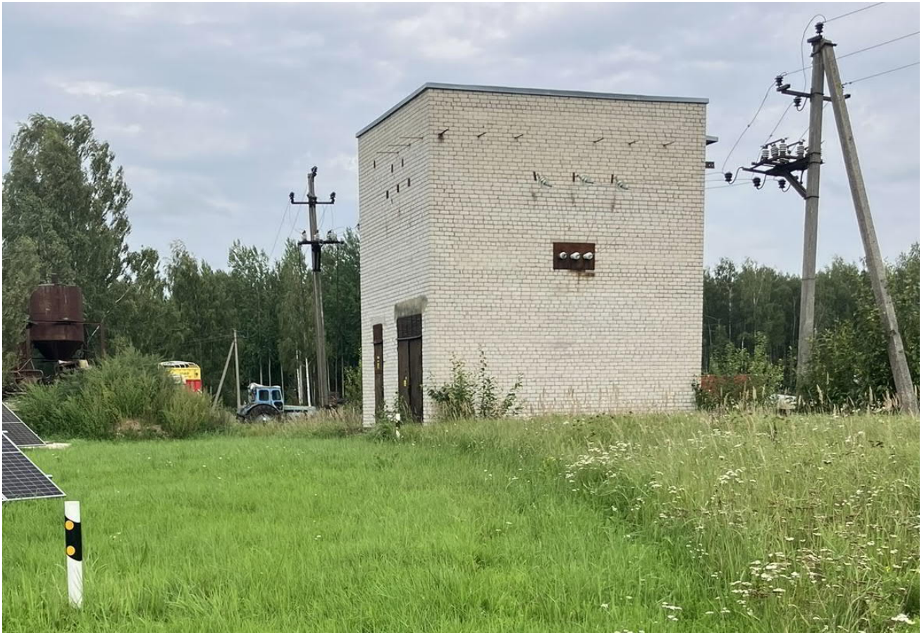
Foto 2.1. Lammutatav Jõgise alajaam - maapealse osa orienteeruvad mõõtmed ca 6,3x7,8x9 m.
