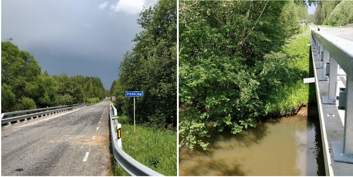
Joonis 1.2. Piusa sild – vaade sillale ja kallastele. Alkranel OÜ, 2024.
