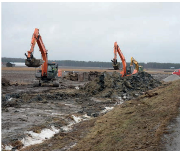
Joonis 12. Hea ehitustava kohaselt teeb parandustöid eraldi tööühm, kes süsteemselt remondib purunenud dreenaži ja liinirajatiste ehitajad saavad oma tööga edasi liikuda. Foto: Rainer Rosendahl
