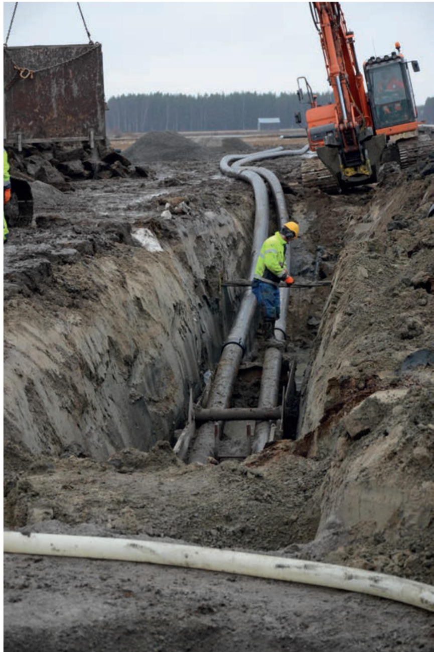
Foto 8. Vee- ja kanalisatsioonitorustiku ehitamine ja drenitoru parandamine.
