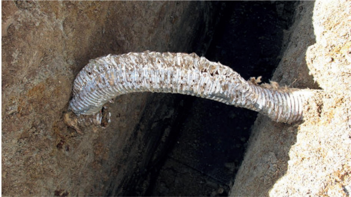
Pilt 6. Läbilõigatud dreenitoru. Foto: Rainer Rosendahl
