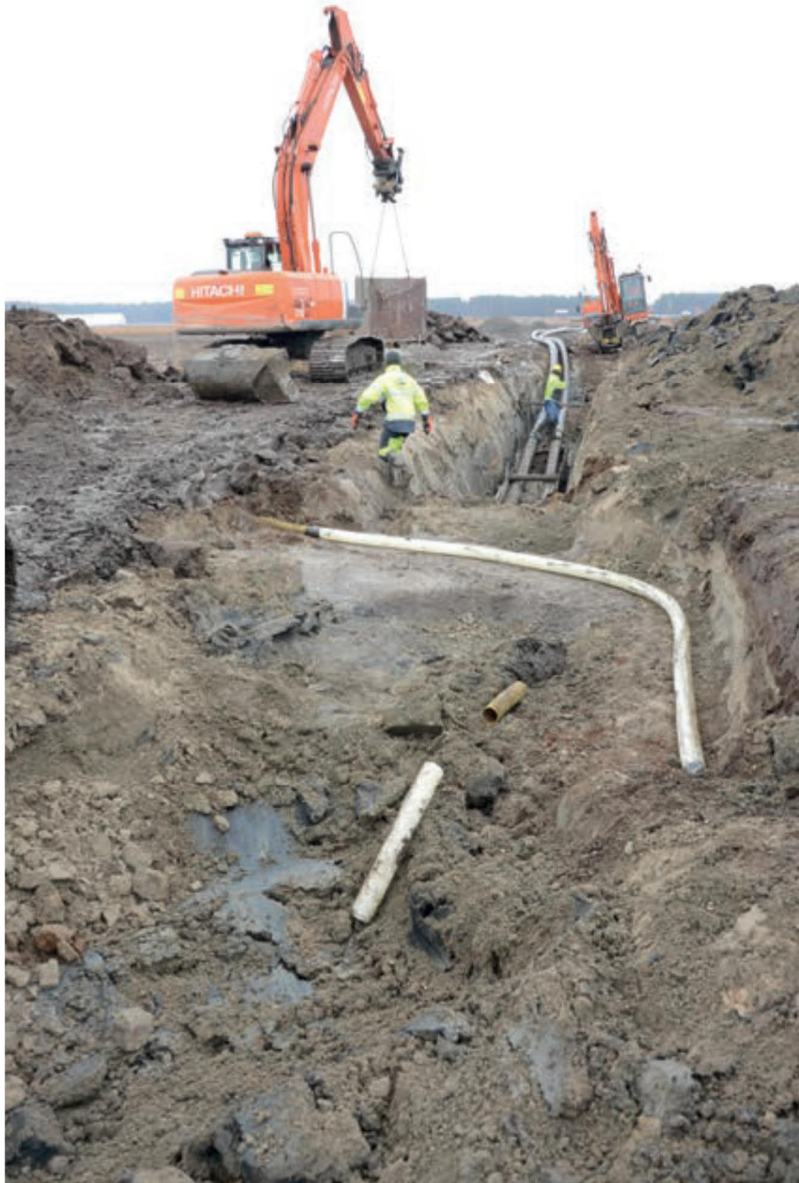
Joonis 10. Dreen parandatakse lisadreeni paigaldamisega, kui liinirajatise kaevik lõikub dreniniga küllalt terava nurga all nii, et liinirajatise trass kulgeb peaaegu paralleelselt drenitoruga rohkem kui 3 m ulatuses. Foto: Rainer Rosendahl
