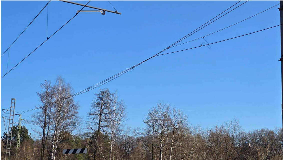
Foto 2: kontaktjuhtme tõstmine / kinnitamine tugifiidrile
