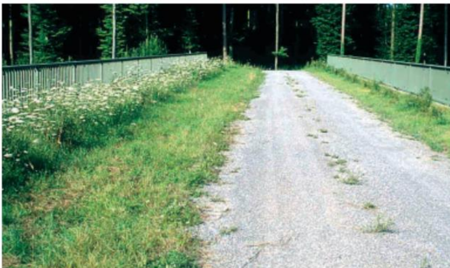
Skeem 3.2.4.3.2. Näide maanteeviaduktist, mille lahendus tagab ülepääsu ka loomadele.
